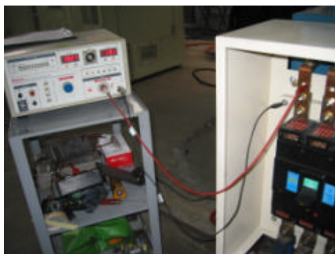
圖 13 對電樞繞組施加耐電壓
