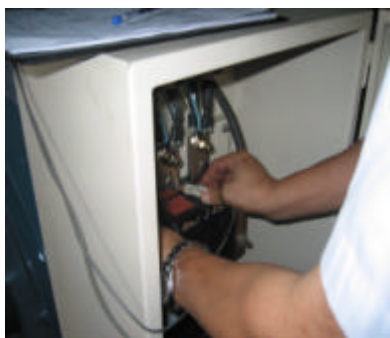
圖 2 電樞繞組電阻量測
