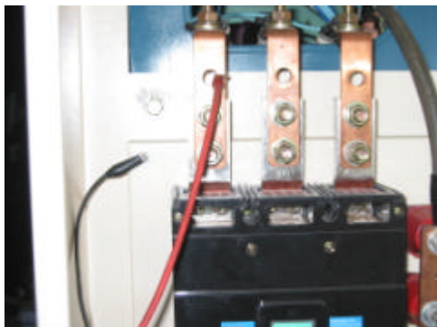
圖 12 測 R 相絕緣電阻情形
