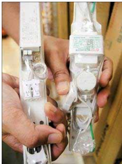
圖 5(左為電子式安定器與右為傳統安定器)
