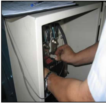
圖 9 電樞繞組電阻量測
