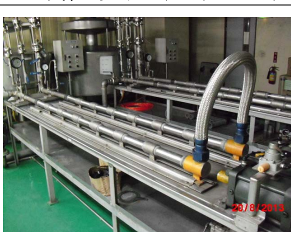
圖 3.1 水量計實驗室 100L/1000L 量槽(左)200L/2000L 量槽(右)
