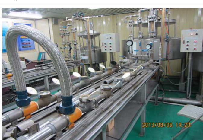
圖 3.2 水量計實驗室 50L/350L 量槽(左)100L/1000L 量槽(右)
