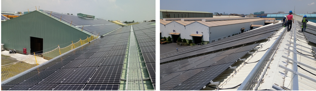
圖2 斜屋頂型支撐架
