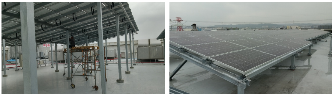
圖1 平屋頂棚架型支撐架
