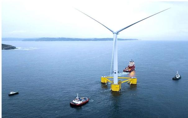
圖 3 Windfloat Atlantic 浮式風場之半潛式平台安裝圖[2]
