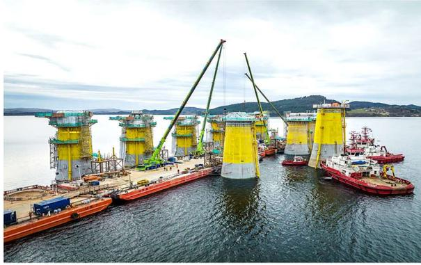
圖 2 Hywind Tampen 浮式風場之浮筒式平台預組裝圖[1]
