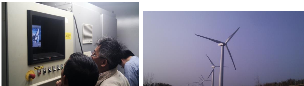
圖 4.5 台灣電力公司風力發電機及內部控制中心
