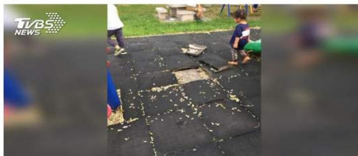
翻起破掉的橡膠地墊，裡面還有積水，位於安南區的兒童遊戲場，主要是在地里民的休閒去處，8月中的大雨下不停，雨滲透到地墊導致變形破損。
